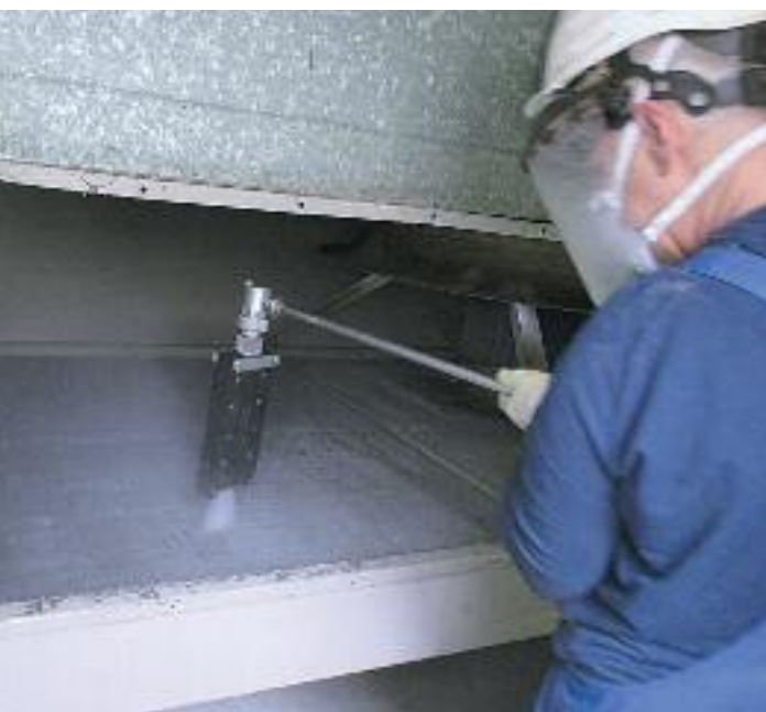
Reinigung von verkalkten Wärmetauschern in einem Krankenhaus
