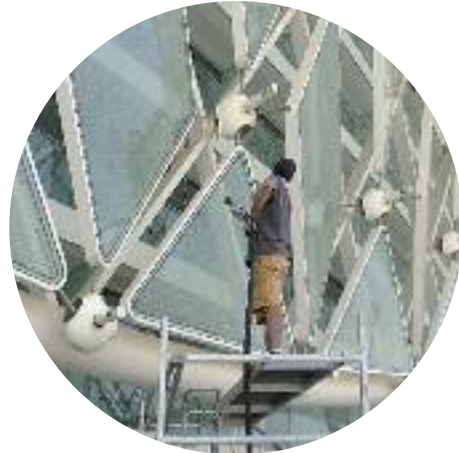
Reinigung Hotelfassade Abu Dhabi
