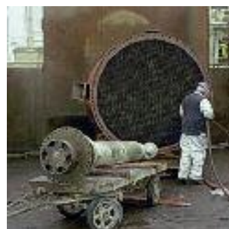
Ausschleifen von 4500 Innenrohren eines Rohrbündelwärmetauschers zur Inbetriebnahme nach längerer Stilllegung
