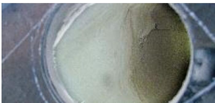
Farbenschichtung in Klima- und Lüftungskanälen in einer Straßenbahn
