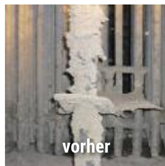
Reinigung Rohrbündel
