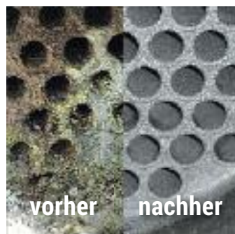
Reinigung eines Wärmetauschers einer Biogasanlage
