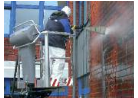
Brandschaden- sanierung einer Klinkerfassade
