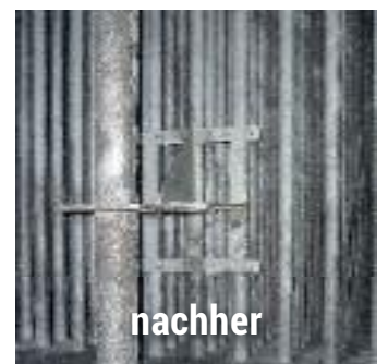
Reinigung Rohrbündel
